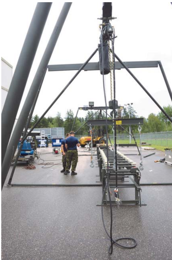
Le système de convoyeur est alimenté par de l'air comprimé, tout comme les deux treuils qui équipent les deux extrémités de la chaîne de montage.
